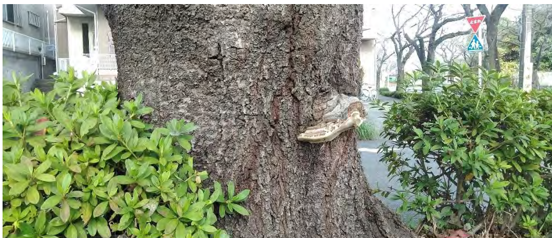
コフキタケが発生した街路樹（樹木の内部が腐食）
