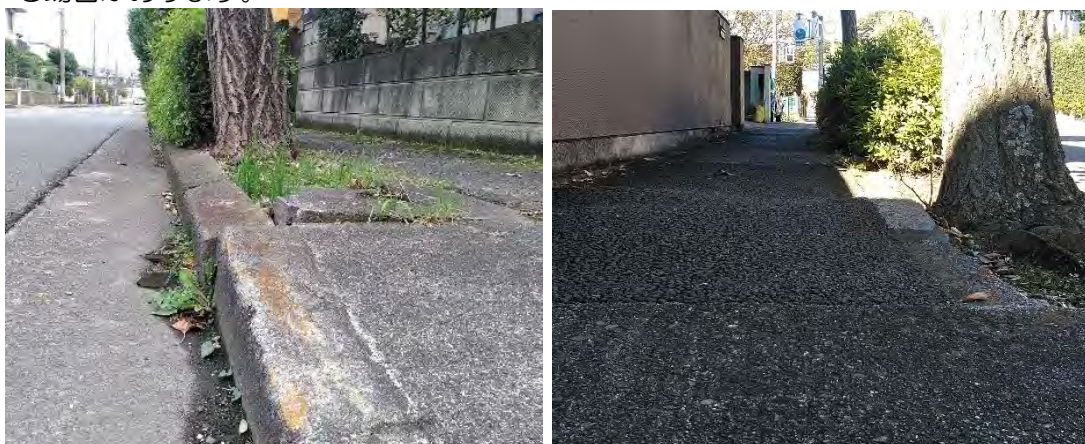
左側：車道側への根上りによる自動車・自転車の走行への支障
