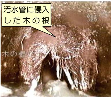
管と管のつなぎ目から木の根が侵入している様子。汚水から栄養を吸収して成長し、管の詰まりや道路陥没の恐れがあります。
