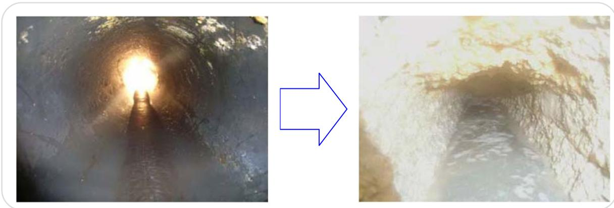
污水管に油脂が堆積した状態
