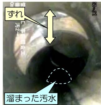
車の振動等により、管がずれた様子。管の詰まりや道路陥没の恐れがあります。
