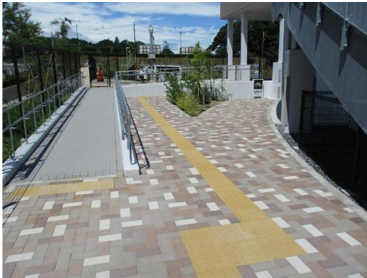
エコセメントが使用された通路（町田市バイオエネルギーセンター）
