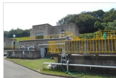
排水浄化センター外観
