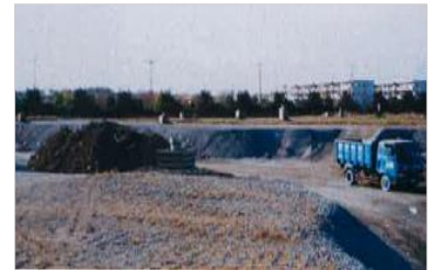
町田市最終処分場
