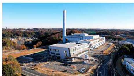
町田市バイオエネルギーセンター
