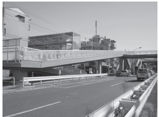
【写真10.1】 スロープの設置例
