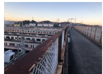
<長津田車庫跨線人道橋>
