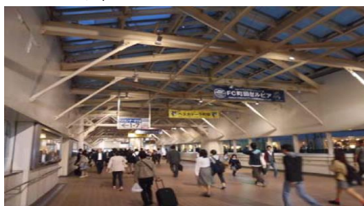
1号デッキ(通路全景)
