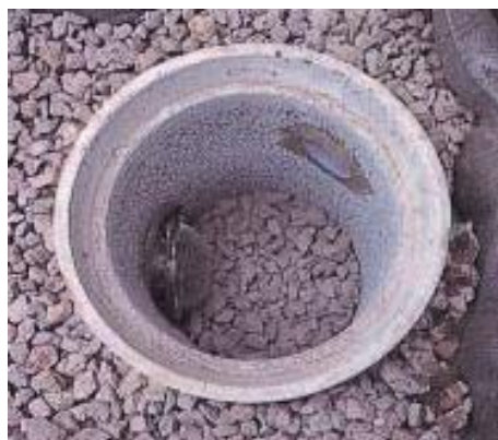
雨水浸透ます
