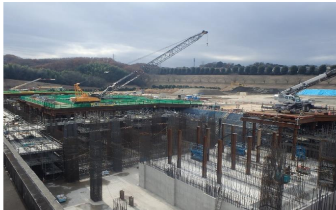
鶴見川クリーンセンター水処理施設増設工事
