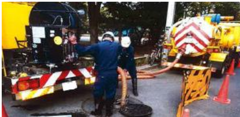
下水道管の清掃作業
