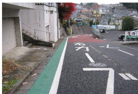
＜交通事故多発箇所改良工事の例＞
