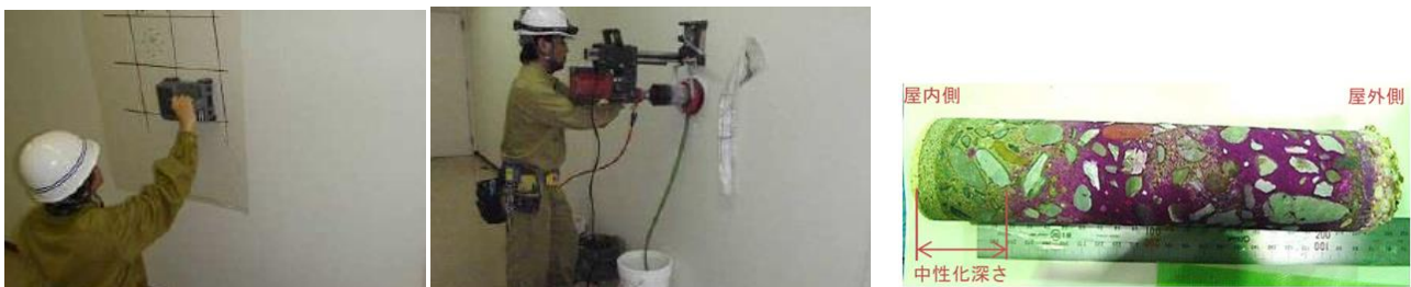
○写真左・中央 コンクリート・コアの採取の様子
