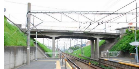
<新小川橋> (東急田園都市線 つくし野駅付近)
