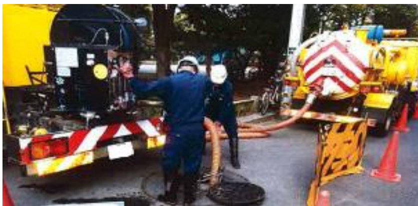
下水道管の清掃作業
