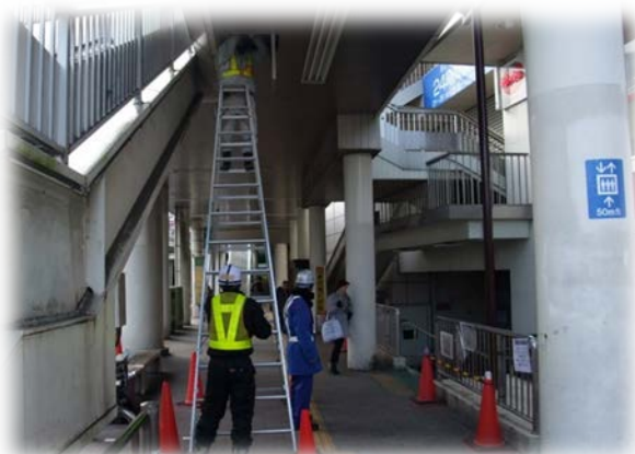
ペDESTリアンデッキの点検
