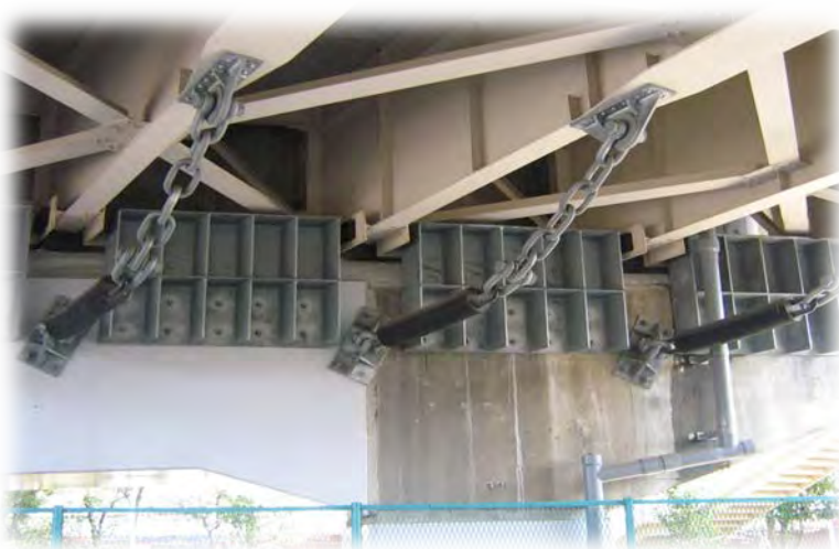
橋梁の耐震補強工事のイメージ図
