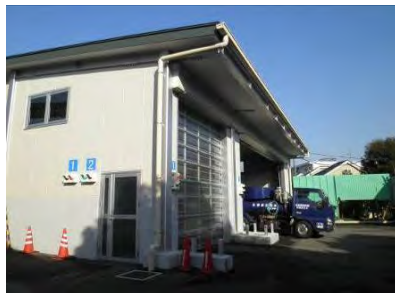
し尿等投入施設外観
