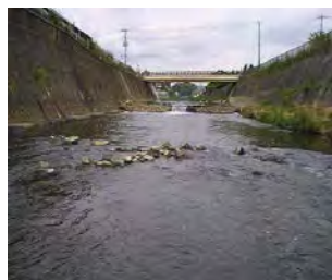
調査対象河川 鶴見川 (麻生橋付近)
