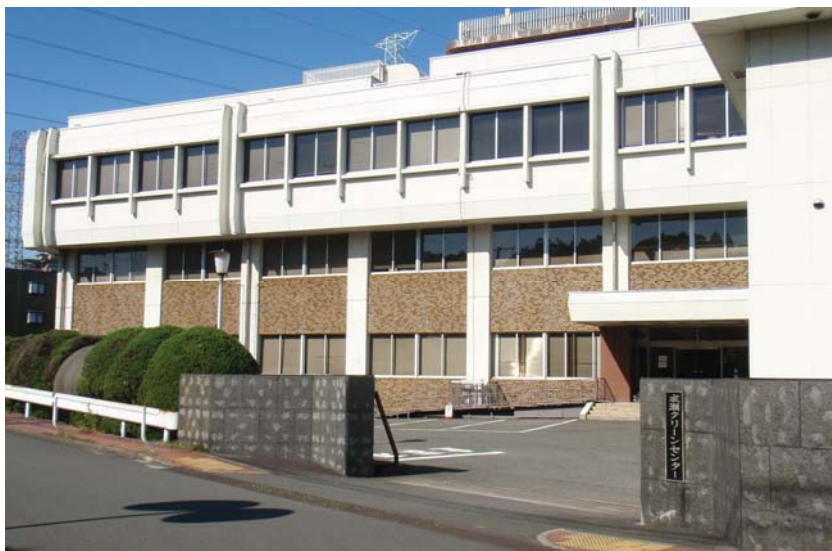
成瀬クリーンセンター管理棟
