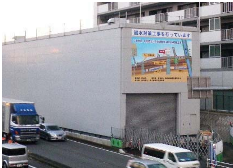
鶴間4号雨水幹線工事
