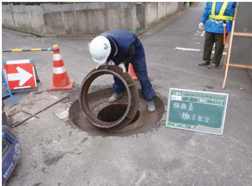
古いマンホールの撤去作業
