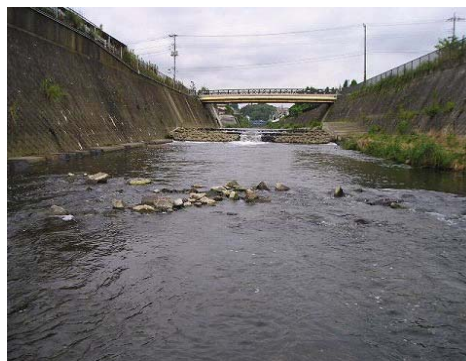
鶴見川(麻生橋付近)
