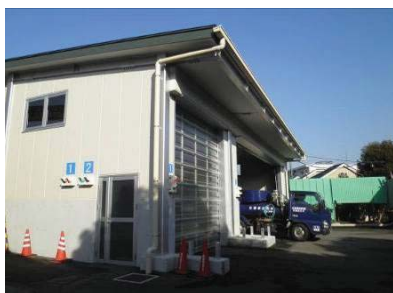
し尿等投入施設外観
