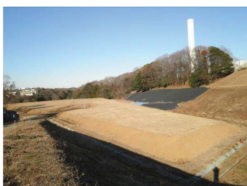
峠谷最終処分場の様子
