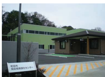
剪定枝資源化センター外観
