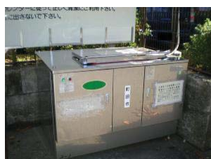
大型生ごみ処理機
