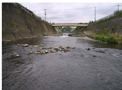
鶴見川(麻生橋付近)
