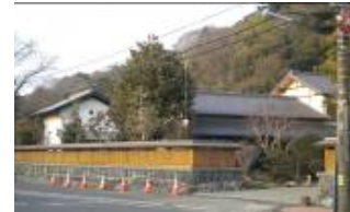
新設された板塀
