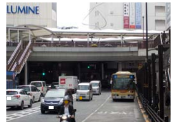
＜ペDESTリアン 3 号デッキ＞ (JR 町田駅周辺)
