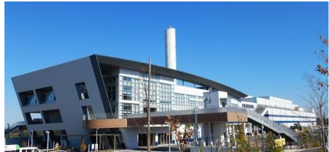
町田市バイオエネルギーセンター(愛称 バイエネ君)
