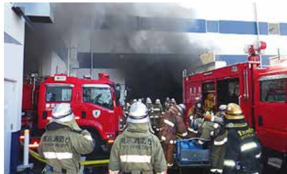
町田市バイオエネルギーセンター(2022年2月火災時の状況)
