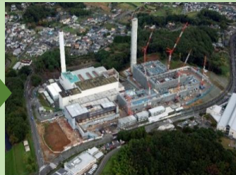
建設中の町田市バイオエネルギーセンター
