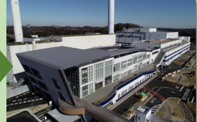
建設後の町田市バイオエネルギーセンター
