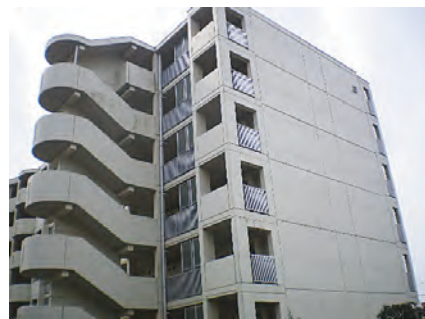
町田市営住宅(忠生市営住宅)
