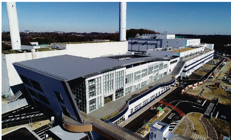
町田市バイオエネルギーセンター
