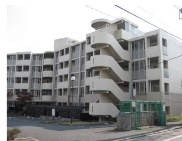
忠生市営住宅
