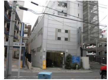
原町田四丁目自転車等駐車場
