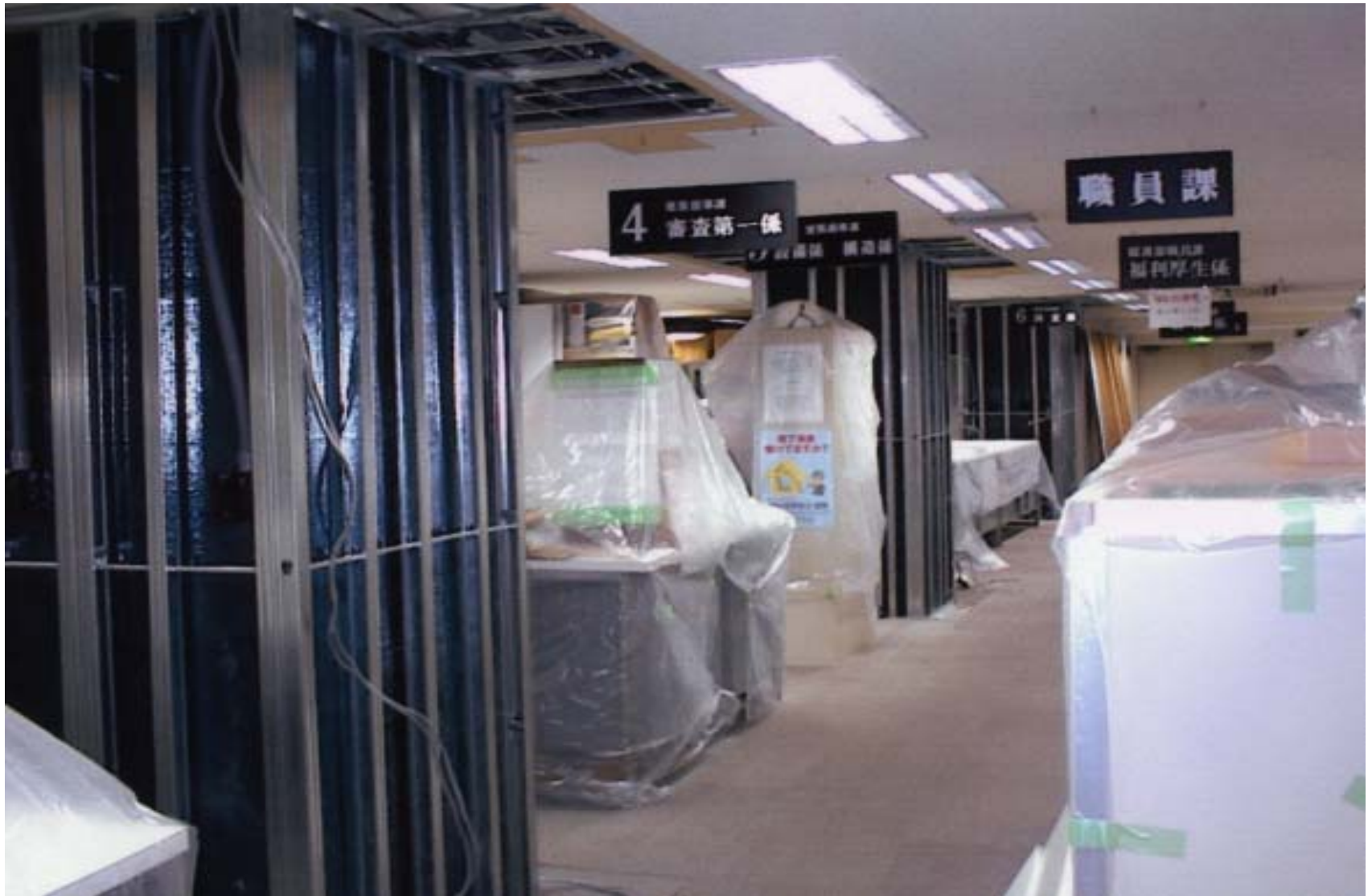
2002年度に実施した本庁舎の耐震補強の様子
