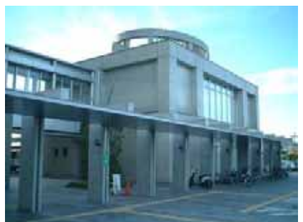
防災センター
