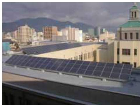
三重県庁屋上に設置された太陽光発電装置
