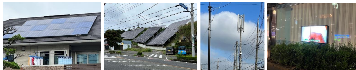
建築物への設置が増加している太陽光パネルの例
