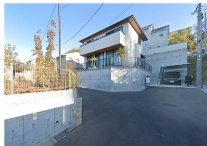
住宅開発に伴う危険性除去による除外 (大蔵町)
