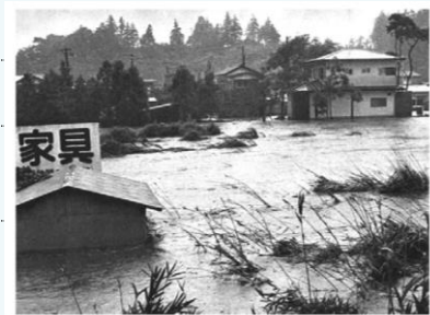
集中豪雨による被害の様子(1972年7月)
