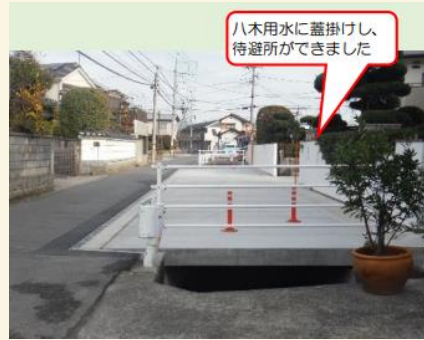
幅員の狭い道路の改良
