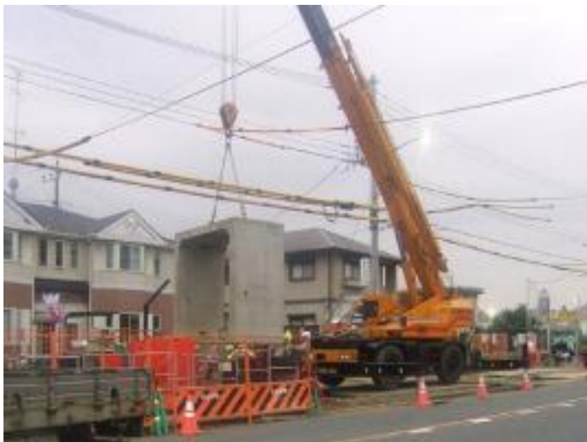
雨水管の整備
