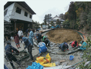
宮城県石巻市で広場をつくっている様子
