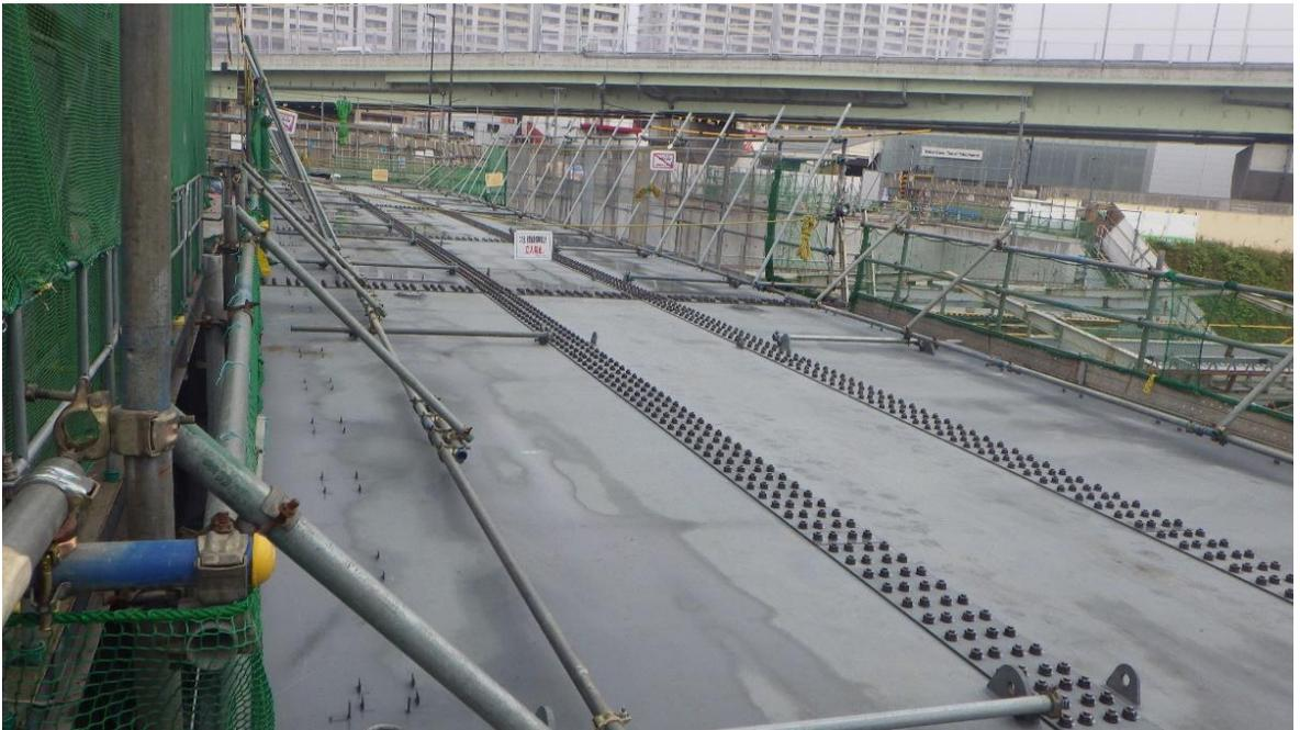
駅の南北を結ぶ幅約7m、延長約46mの自由通路は、10月に桁の架設を完了させました。写真は、夜間に巨大なクレーンを使い、桁を架設している様子と、架設後の様子です。
