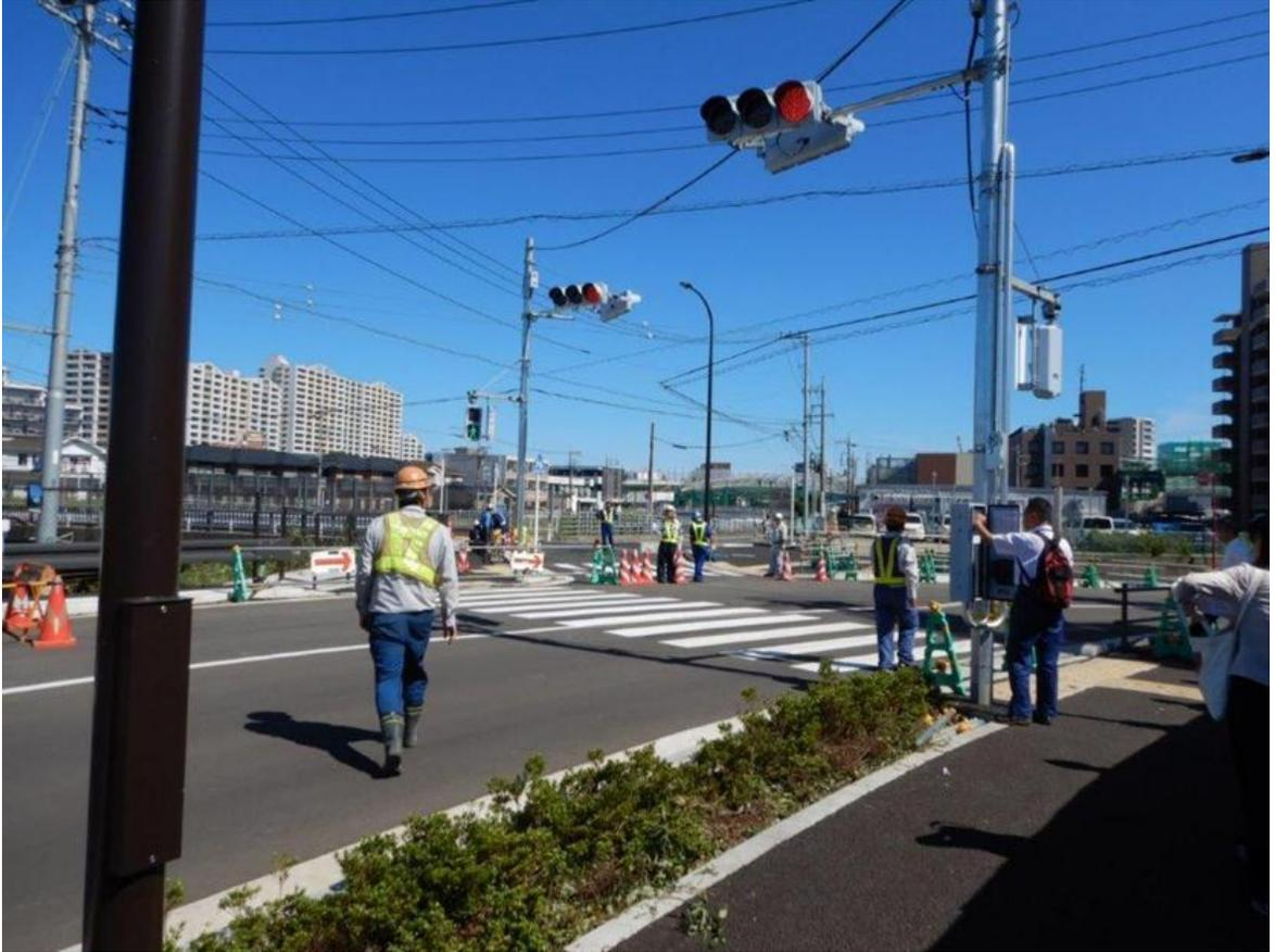
10月1日には、今年6月に開通した新設道路の東側と西側の交差点に、歩行者が安全に道路を横断できるよう、新たな信号機を設置しました。写真は、警察の立ち合いのもと、信号機の点灯確認をしている様子です。
