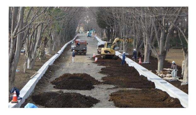
鶴間公園の中でも工事が進んでいます。横浜水道道路では、適切な雨水処理のために、道路の両脇に排水設備を整備します。これに伴い、盛土を施す際には、並木のケヤキなどの樹木を保護しながら、工事を進めています。
