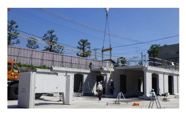
鶴間公園の南側では、境川とつながる調整池の貯水容量を、おおよそ2倍にするため、大規模な工事が進められています。写真は、2017年度工事のPCブロックの据え付け工事の様子です。調整池は、上部利用ができるように蓋をかけ、運動公園のスポーツコートなどとして利用します。
