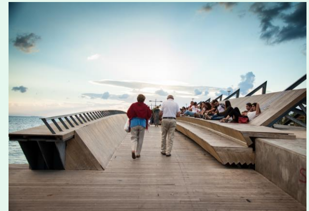
ポスターリ歩道橋
