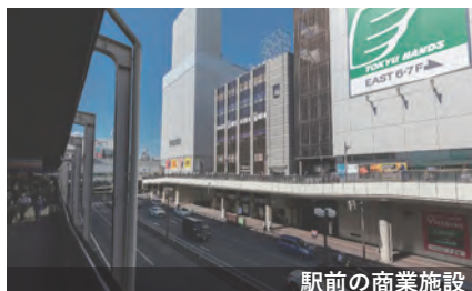
駅前の商業施設
