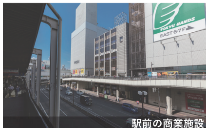
駅前の商業施設
