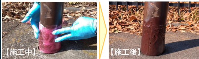
事例)FRP※シートを用いた簡易工法(町田市)
