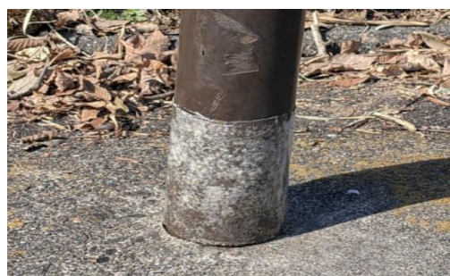
(施工後) 補強した鋼管柱
