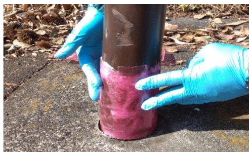
(施工中) FRPシートの巻き付け作業を実施
