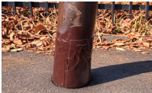
(塗装後) 塗装した鋼管柱
