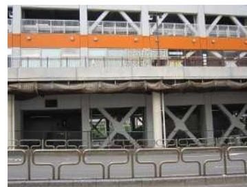
図 3.3 措置実施後（ネット設置）
