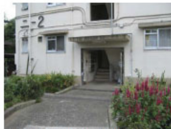
5階建てでエレベータの無い住宅棟
