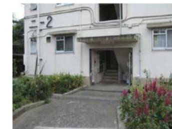
5階建てでエレベータの無い住宅棟
