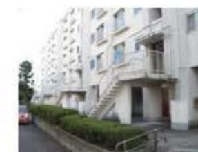
エレベータの無い住宅棟
