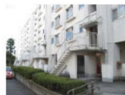
エレベータの無い住宅棟
