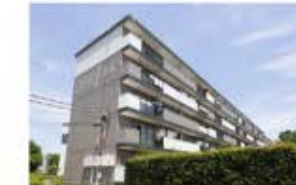
外壁修繕により、自然と調和した落ち着いた 落ち着いた外観に生まれ変わった住棟
