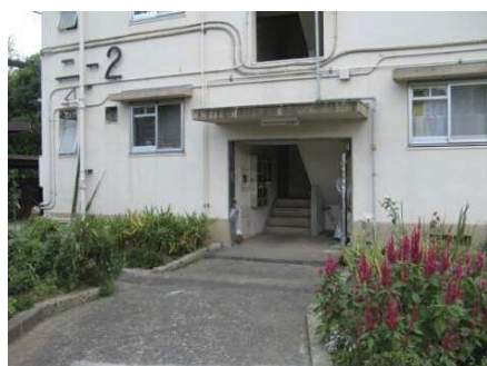
5階建てでエレベータの無い住宅棟
