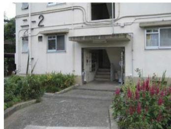
5階建てでエレベータの無い住宅棟
