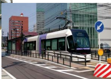
低床車両やスロープ設置によるバリアフリー化
