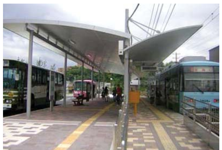
路面電車とバスとの乗換え導線の工夫 (廿日市市役所前駅)
