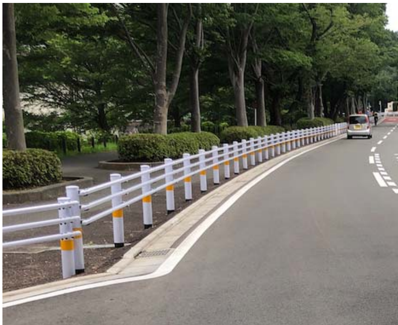
図 3-2-5 ガードパイプと横断抑止柵の設置
