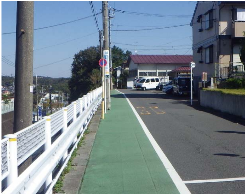
図 3-2-4 カラー舗装の実施
