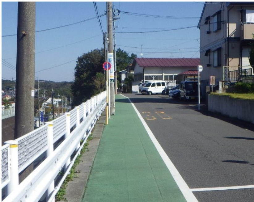
図 3-2-4 カラー舗装の実施
