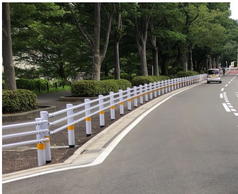
図 3-2-5 ガードパイプと横断抑止柵の設置
