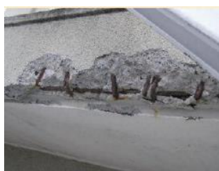
欠損による鉄筋の露出
