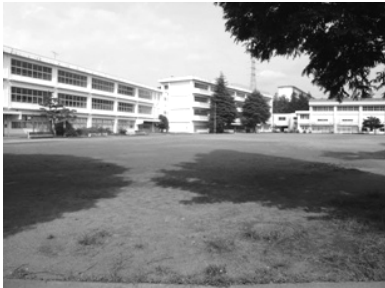
① 旧忠生第六小学校用地 敷地面積：17,354 m 2
